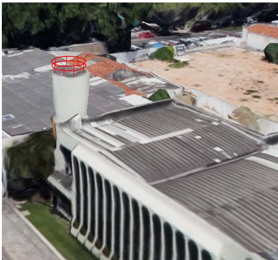
Figura 13 - Local da instalação do guarda corpo.
